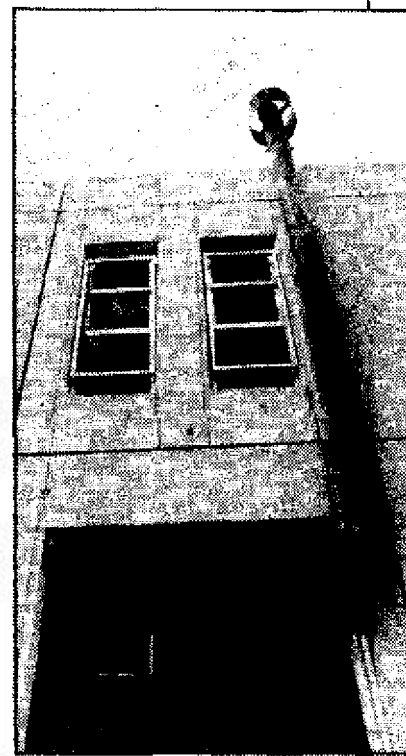
Por estas ventanas entraron los autores del robo (Foto: Litus).
