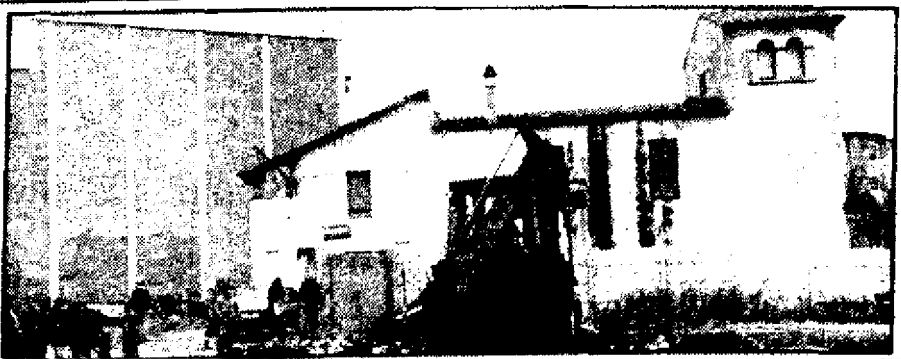
Estos trabajos permiten la instalación de los feriantes.
