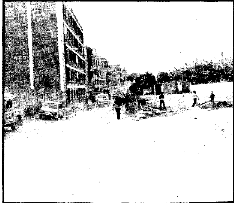
Tiraron la valla del Gramenet para agrandar el acceso "imposible" de calle Verdi. (Foto: Mares).
